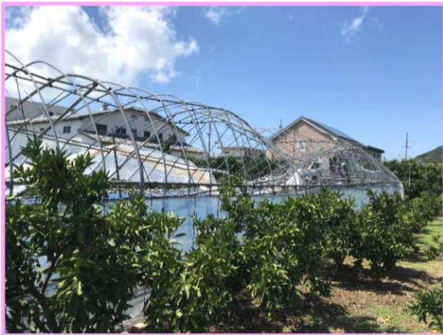
ハウスの骨組みまで変形
