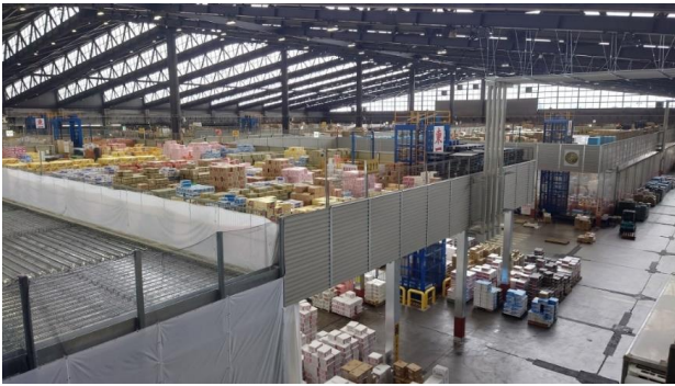
大田市場の二層化工事
